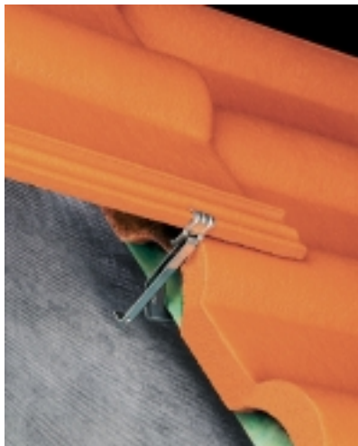
↑ Anschließend wird bei der Universal-Sturmklammer der Zuganker umgebogen.
