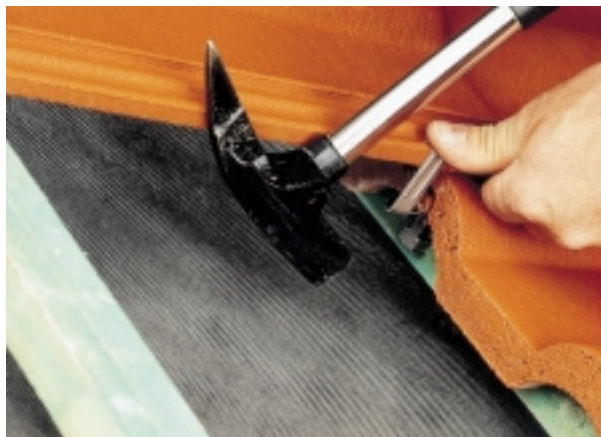
← Die Euro-Sturmklammer wird in den Seitenfalz eingelegt und mit dem Hammer eingeschlagen.
