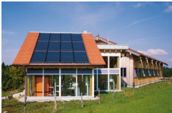
Sonnenenergie fürs Trinkwasser: Sechzig Prozent der Energie zur Wassererwärmung kommt von der Sonne. Foto: Braas Dachsysteme
