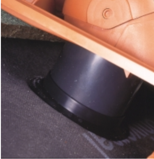
Anschlussring eingedreht
