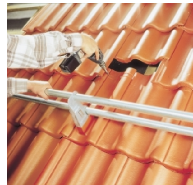
W Schneefangpfannen werden mit ausreichend langen Schrauben auf der Traglattung befestigt.
