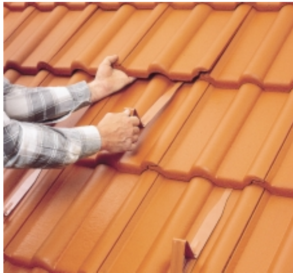
a Die Schneestopphaken werden nach der Eindeckung im rechten Wasserlauf verlegt.
