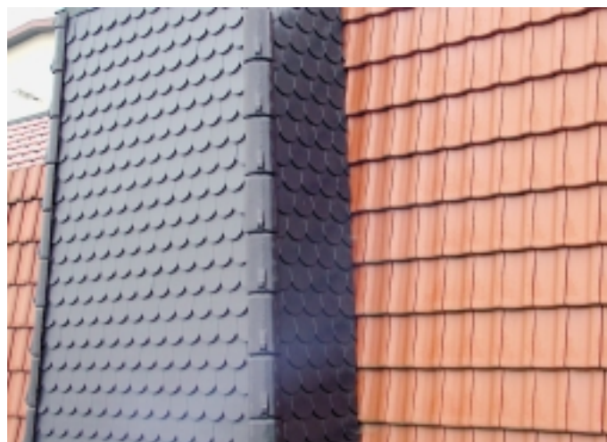
◀ Wandbekleidung mit Topas-Reformpfannen und Opal-Biberschwanzziegeln.
